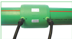
5. นำเช็ทของเครื่องเชื่อม E.F. มาเสียบเข้ากับข้อต่อ
