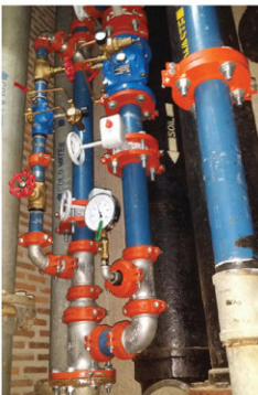
ภาพการติดตั้ง PRV กับท่อ SYLER
